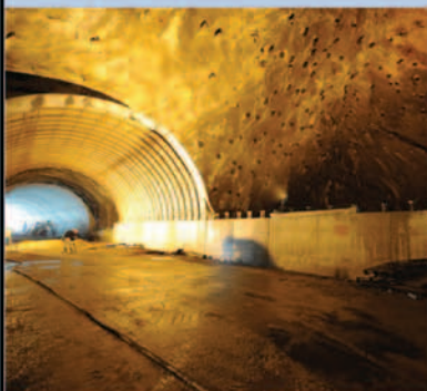
Sanacija svoda speleološkog objekta
