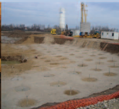
Ojačanje tla mlaznim injektiranjem
