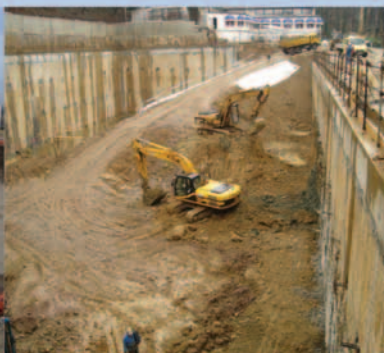
Zaštita iskopa duboke građevne jame
