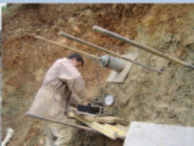
Ispitivanje nosivosti sidara
